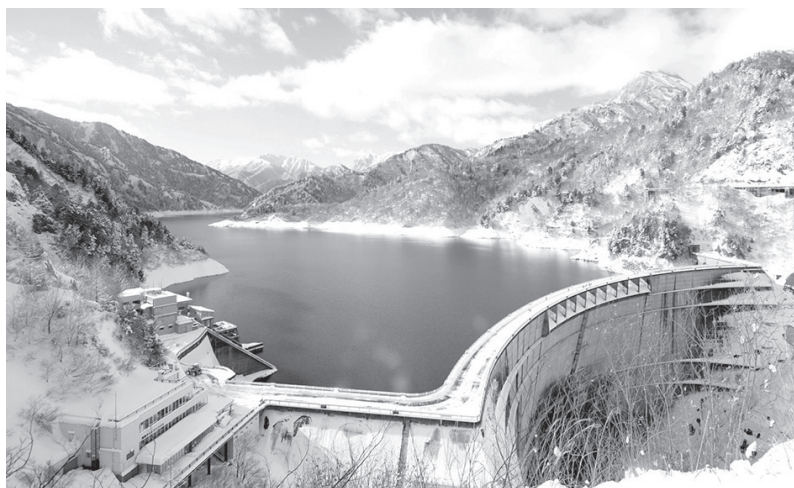
雪におおわれた黒部ダム
